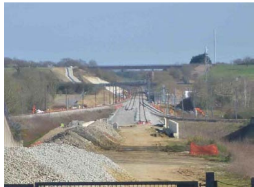
図2 フランスにおける鉄道土構造物の施工現場 (TGV 建設現場、著者撮影)
