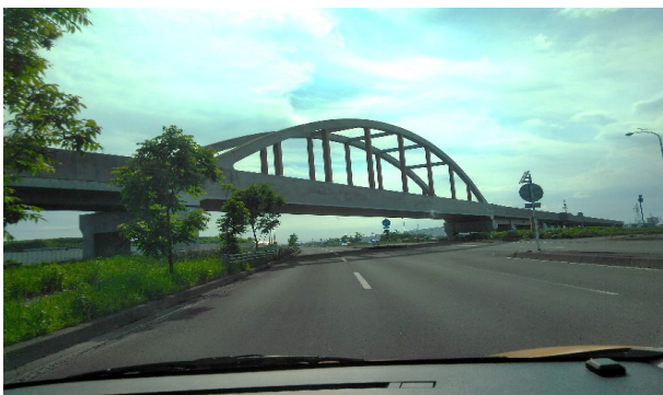
図3 新大楽毛高架橋 (道道860号星が浦海岸通架道アーチ橋)
