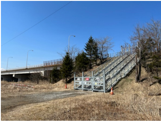
図2 盛土上の高規格道路（釧路新道）に設けられた避難用階段
